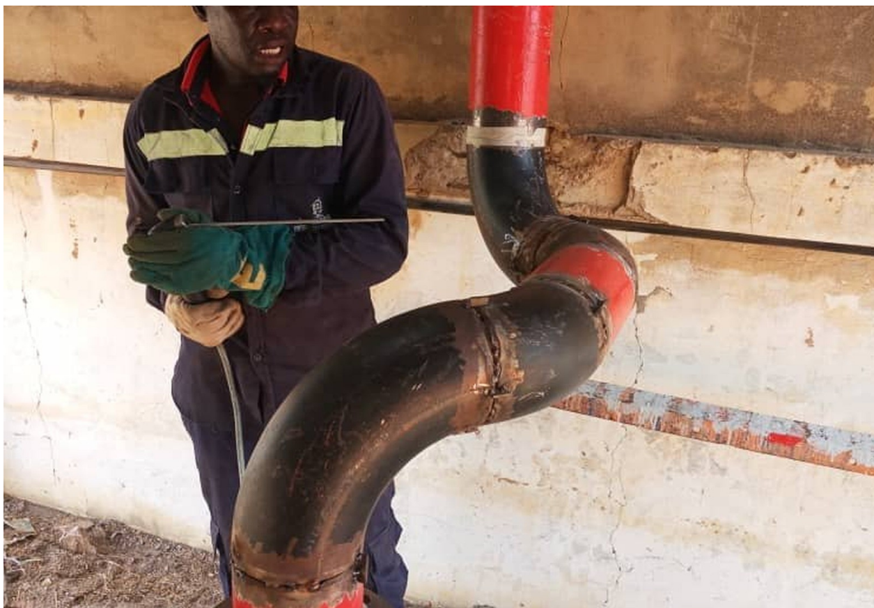
La maitrise technique, la qualite et la securite restent au coeur des interventions E2I.
