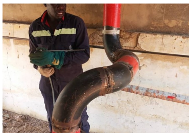
Travaux de soudage
